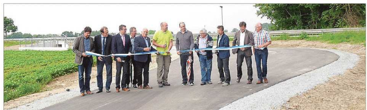
Im Juni erfolgte die Verkehrsfreigabe für den Lückenschluss der Radwegeverbindung Aiterhofen-Straßkirchen.
