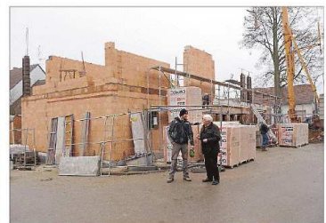
Mit den Bauarbeiten für das neue Bürgerhaus in Geltolfing wurde begonnen.
