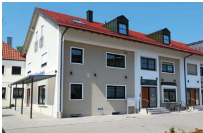
Das Gebäude an der Nordwestseite der Rosengasse ist durch Bank, Büros und einem Friseurladen genutzt.
