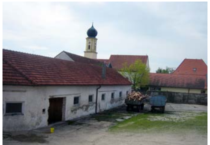
Ostgebäude südlicher Teil mit Pferde- und Schweinestall
