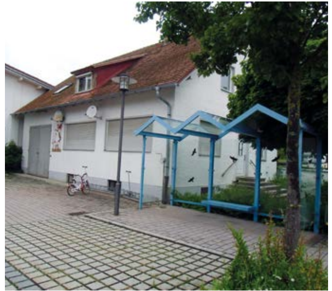
Der Abbruch des alten Gemeindehauses erfolgte 2012.
