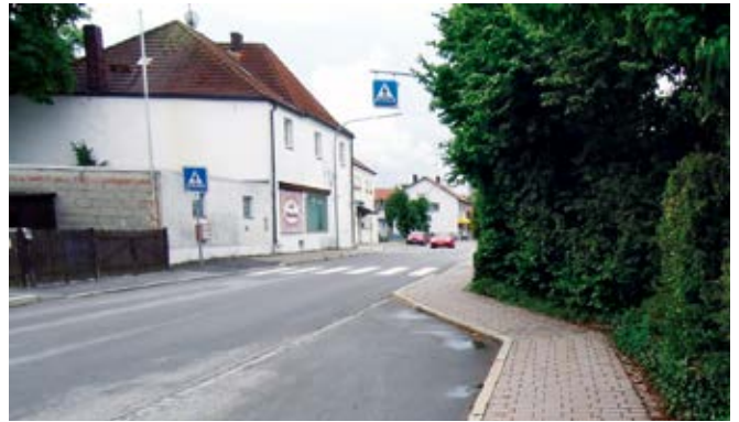
Mit dem zunehmenden Straßenverkehr in der Brückenstraße wurde hauptsächlich für die Schulkinder ein gut beschilderter Zebrastreifen angebracht.
