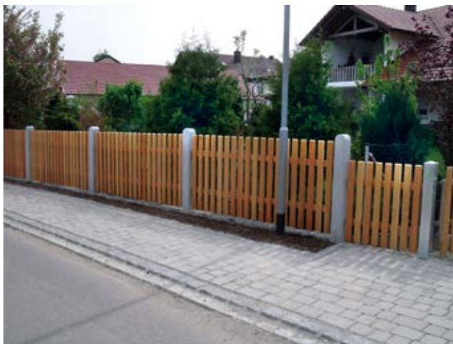
Fertigstellung der neuen Zäune.
