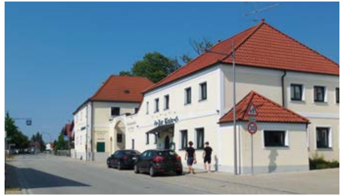
Die Gaststätte wurde neu gestaltet sowie mit einem Nebenraum und einer neuen Küche erweitert sowie Parkplätze für PKW.
