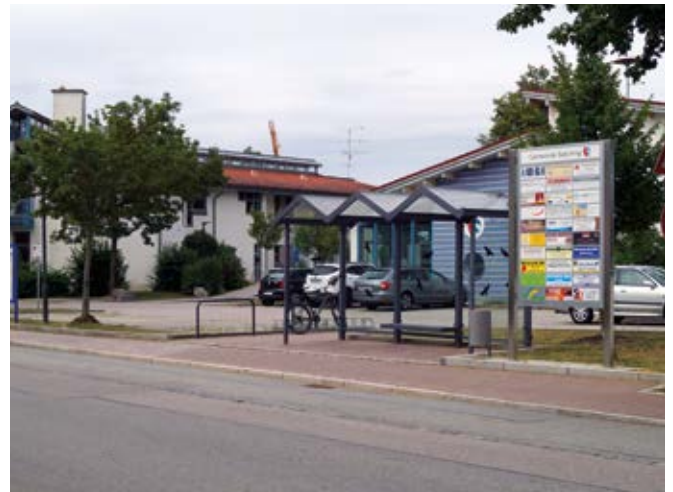
Für die Bushaltestelle wurde auf der westlichen Straßenseite eine Parkbucht gebaut und das Wartehaus dazugestellt.
