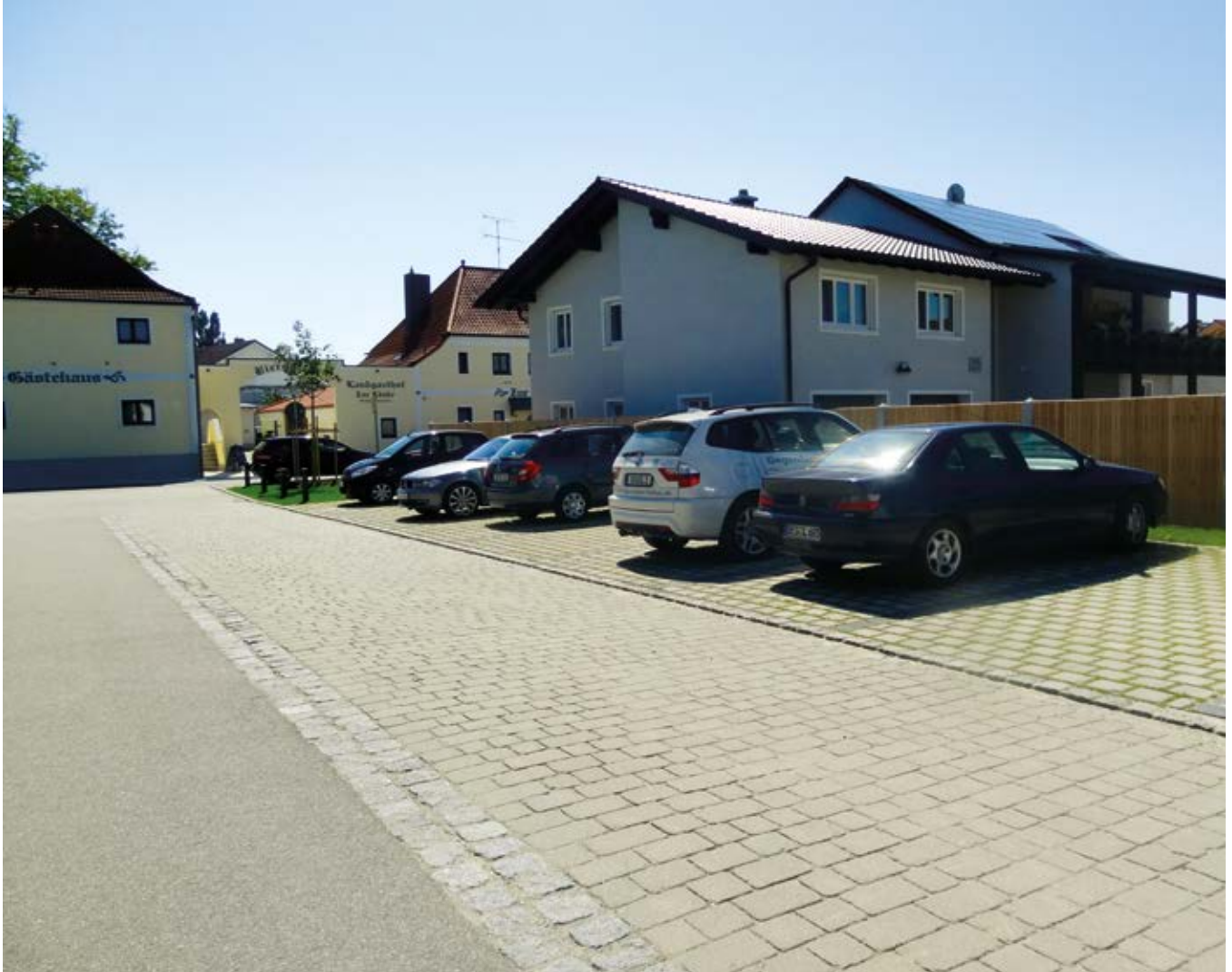
Das Gebäude-Ensemble „Gasthaus zur Linde“ und Wurm/Dallmeier.
