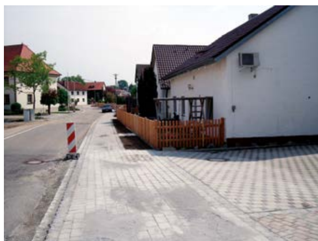
Fertigstellung des Gehweges.
