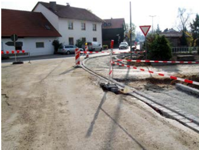
Umfangreiche Gehweg- und Zaunbaumaßnahmen an der Westseite der Kirchstraße.
