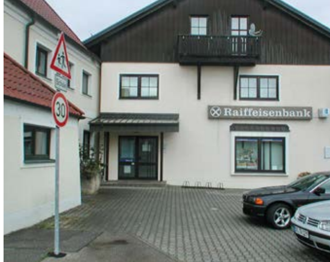
Vor der Umgestaltung diente der Platz zwischen Bank und Gasthaus als reine Parkfläche.
