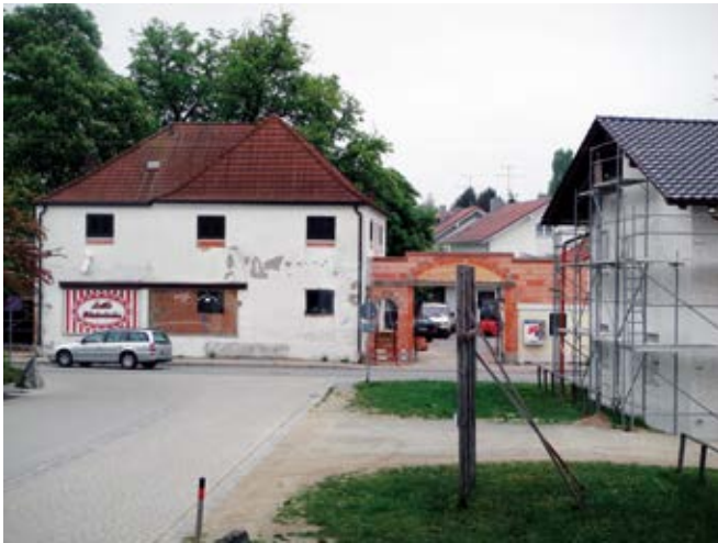
Bau der Parkplätze vor der Schule.
