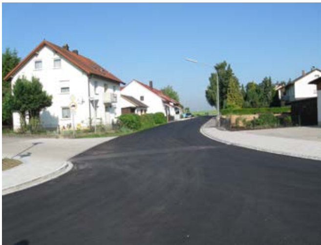
Fertigstellung der Kirchstraße Nord und Einmündung in die Brückenstraße.
