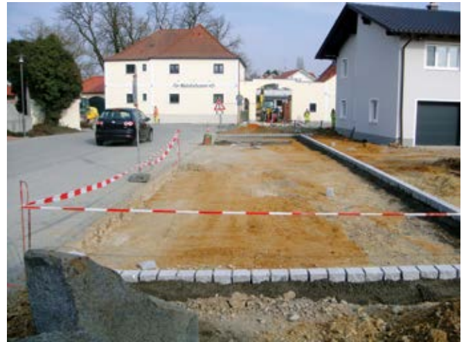
Die frühere Einfahrt zum Dallmeierhof wird für den Bau der Parkplätze vorgesehen.
